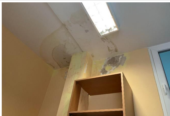
Obr. 2 Zatékání okolo svodu (vedený v kastlíku)
