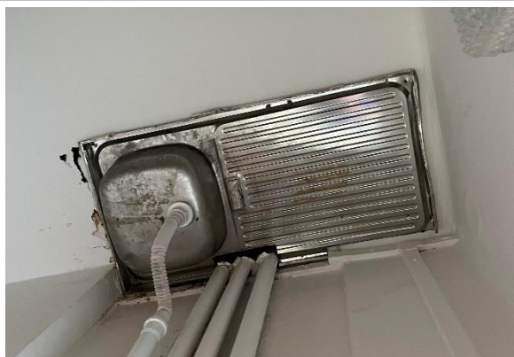
Obr. 4 Zátékání v oblasti terasy navazující na stěnu 2.NP – dřez zajišťuje odvod vody
