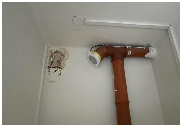
Obr. 5 Zátékání v oblasti terasy navazující na stěnu 2.NP
